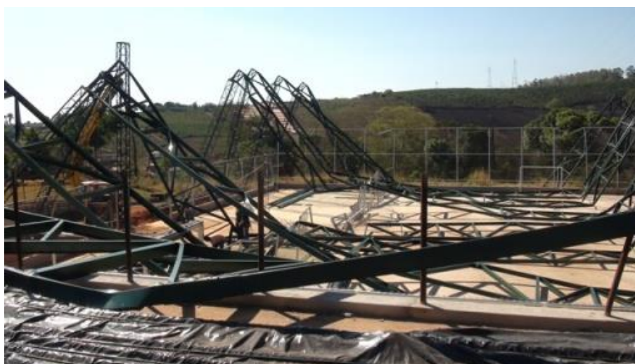
Figura 5 - Quadra poliesportiva em Lavras-MG destruída pela ação do vento.
