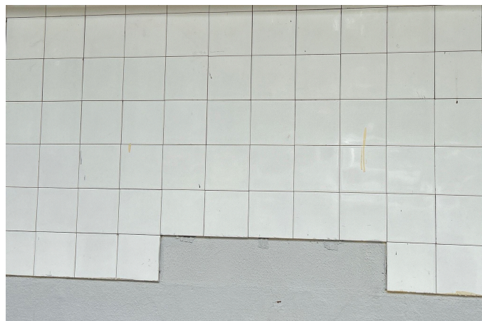
Figura 10 - Desplacamento localizado da cerâmica
