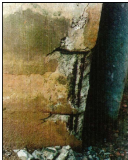
Figura 4 - Deterioração típica de “pé” de pilar com destacamento do concreto de cobrimento e exposição das armaduras
