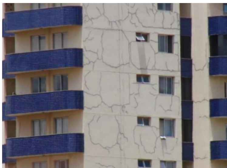
Figura 5 - Fissuras Mapeadas
