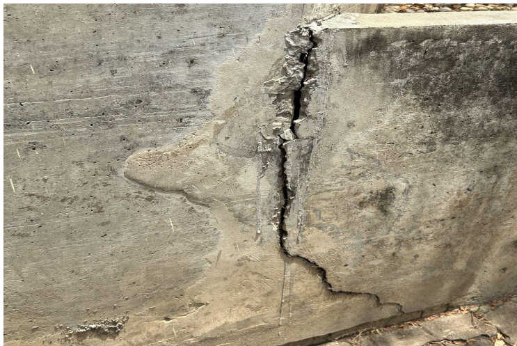
Figura 3 - Deslocamento de Placas
