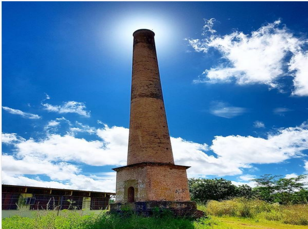
Figura 11 – Chaminé - único resquício da monumental fábrica União.
