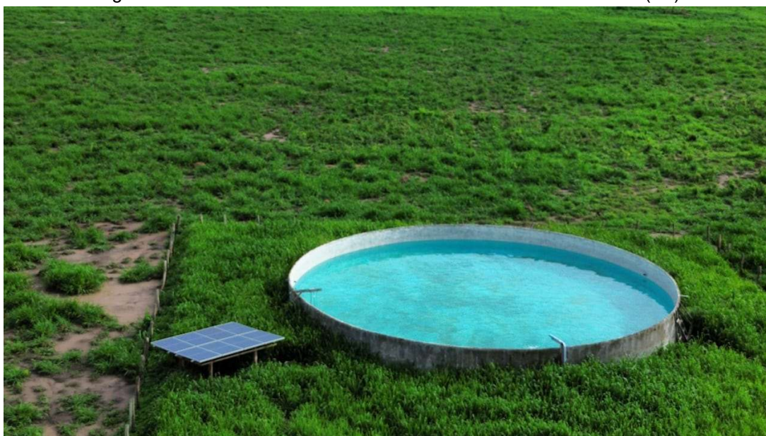
Figura 15: Reservatório Secundário com Sistema Eletromecânico (B3)
