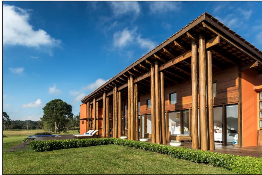
Figura 2 – Utilização da madeira roliça em pilares
