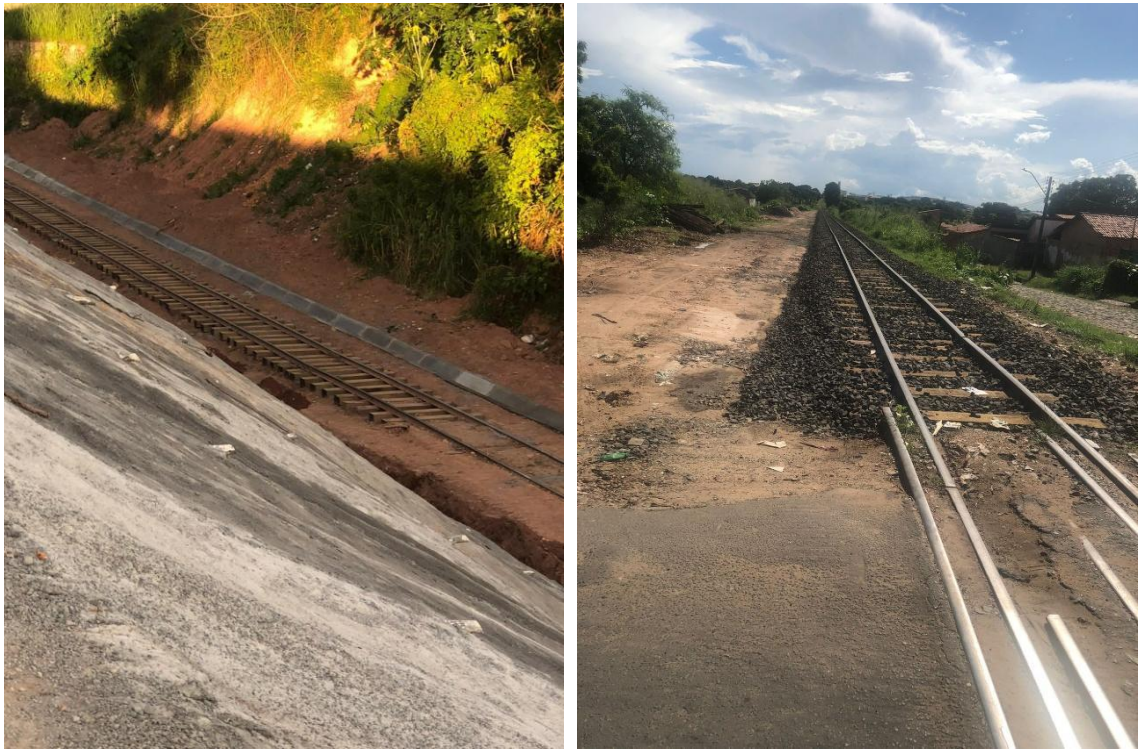
Imagens 5 - Substituição dos dormentes de madeira (à esquerda) e (à direita) requalificação dos lastros de brita
