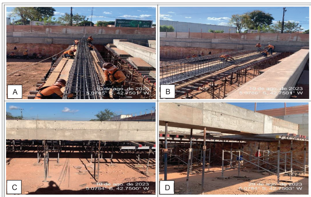
Figura 14 - Viga de contraventamento - Armação e escoramento.
