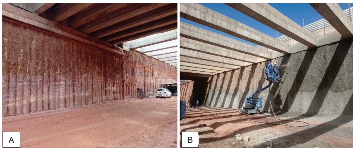
Figura 18 - Condição inicial da cortina de estacas escavadas sem revestimento e aplicação do concreto projetado para proteção superficial.
