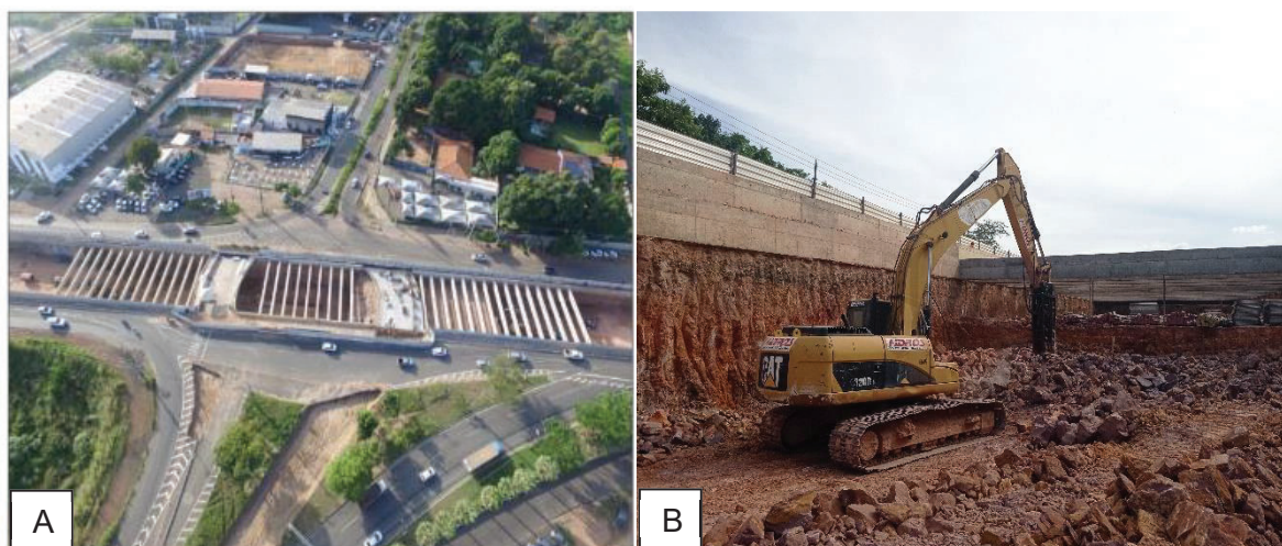
Figura 17 - Escavação de material de 3ª categoria no trecho central da trincheira.
