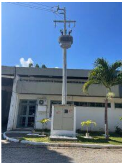
Figura 5 - Exemplo de instalação de subestação aérea.
