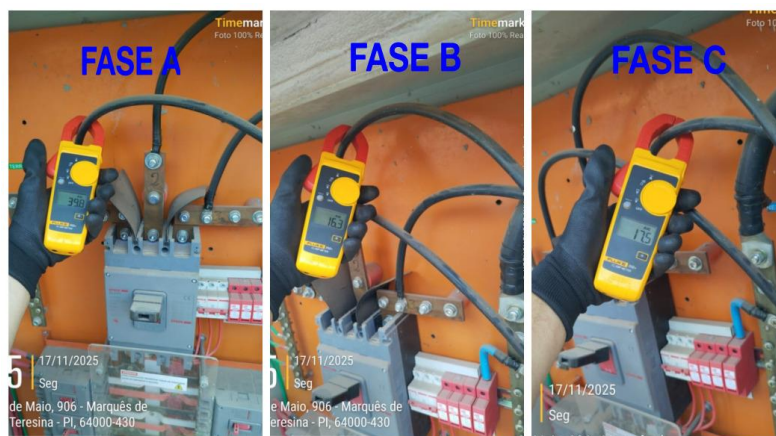
Figura 27 - Medições das correntes das fases A, B e C na Subestação A.
