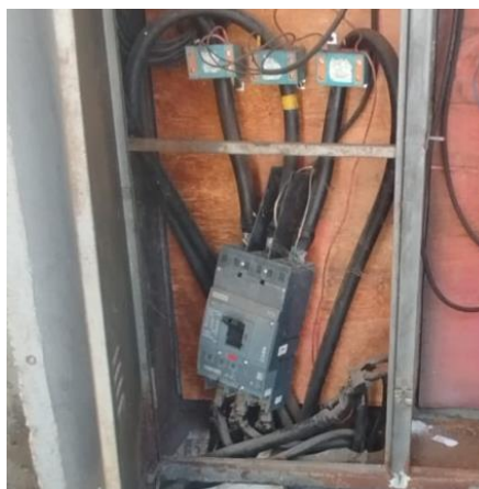
Figura 22 - Disjuntor e cabo da Subestação B.
