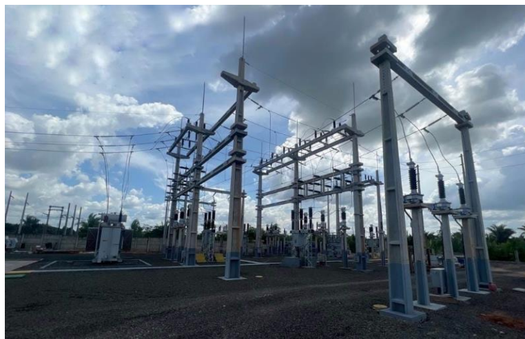
Figura 7 - Subestação ao tempo, mostrando a disposição dos equipamentos ao ar livre.
