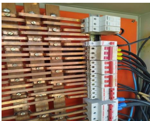
Figura 26 - Detalhes do barramento do QGBT.
