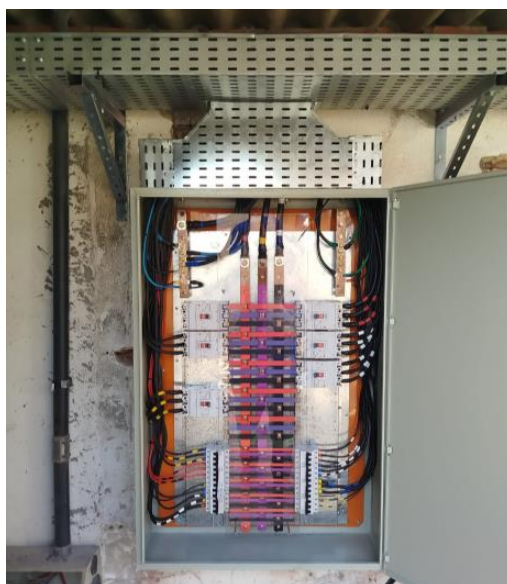
Figura 41 - QGBT da subestação B com novos barramentos adaptados.
