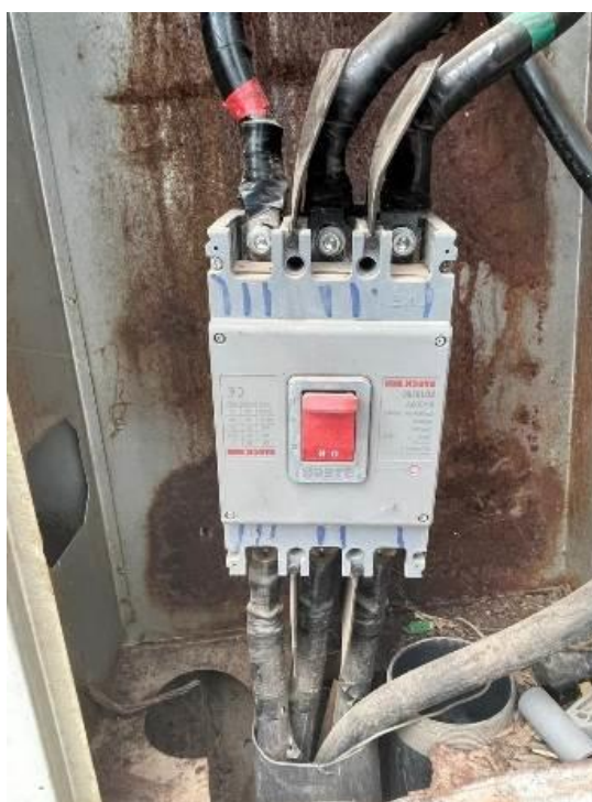
Figura 20 - Disjuntor e cabo da Subestação. A.
