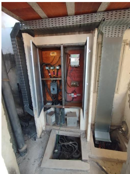
Figura 42 - Instalação de eletrocalhas para melhor organização dos circuitos.
