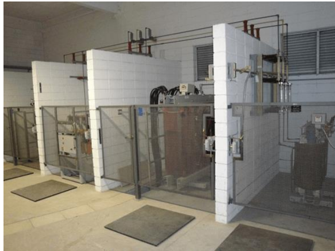
Figura 6 - Exemplo de subestação abrigada.
