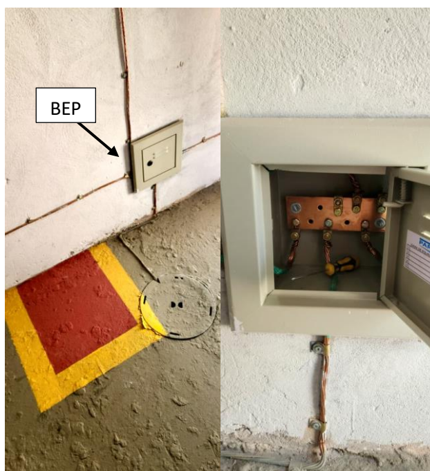
Figura 22 e 23 – Barramento de Equipotencialização (BEP)
