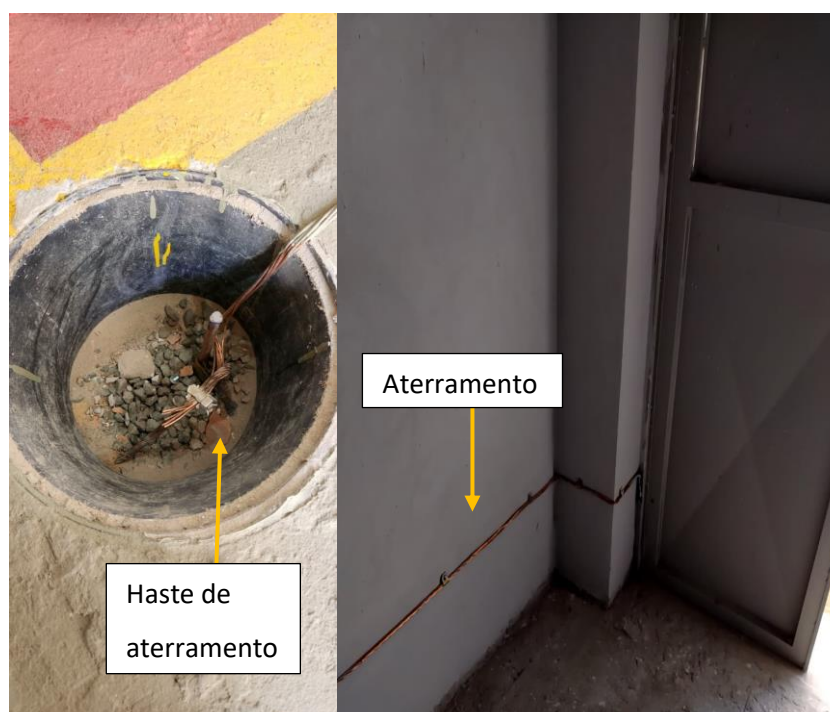
Figura 24 e 25 – Haste de aterramento e aterramento de partes metálicas
