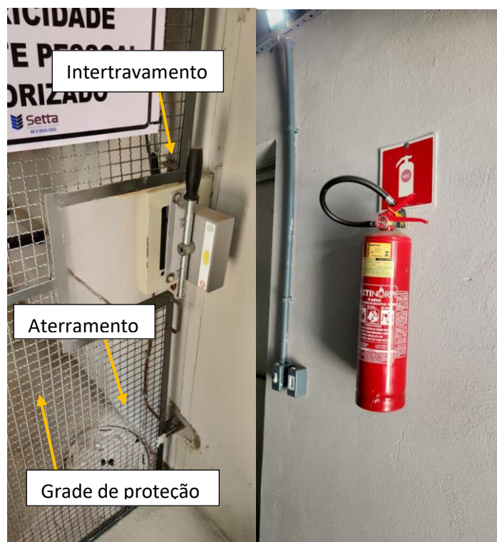
Figura 26 e 27 – Intertravamento mecânico/elétrico e Extintor de incêndio
