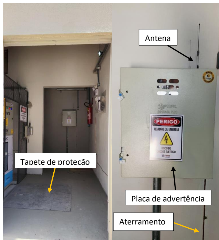
Figura 30 e 31 – Entrada do Cubículo e Centro de medição remoto
