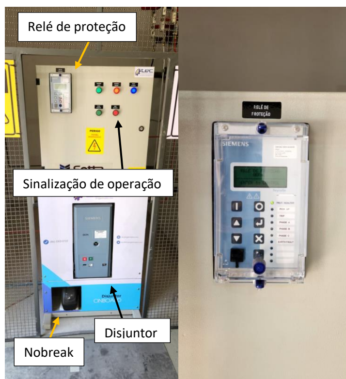
Figura 28 e 29 – Cabine de proteção e Relé de proteção
