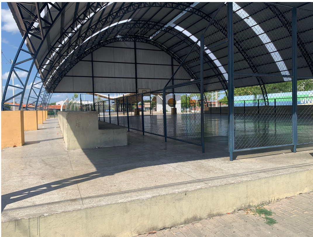
Foto 11: Estrutura interna da quadra poliesportiva com cobertura metálica e cercamento
