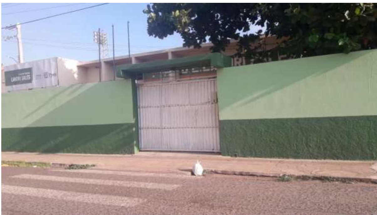
Figura 1. Fachada da escola Unidade Escolar Landri Sales, município de Picos, Brasil.
