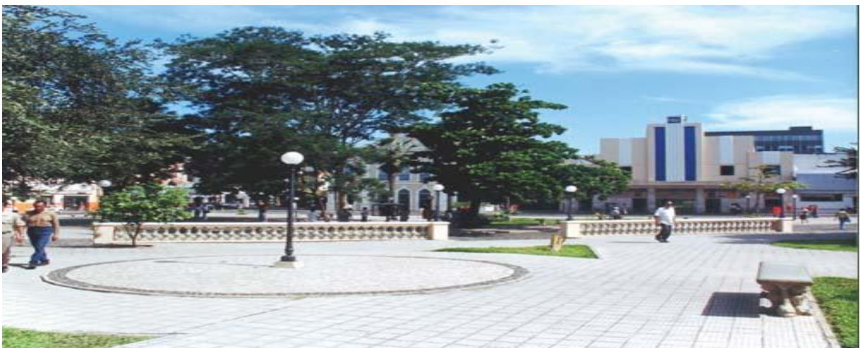
Figura 3- Praça Pedro II, após a reforma de suas estruturas primárias. Fonte: Disponível em:< https://patrimoniospiauienses.wordpress.com/tag/patrimonio-imaterial/ > Acessado em: 1º jul. 2018.
